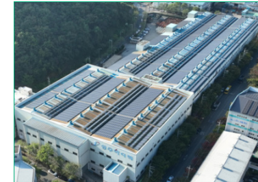
지사공장 태양광 발전소
