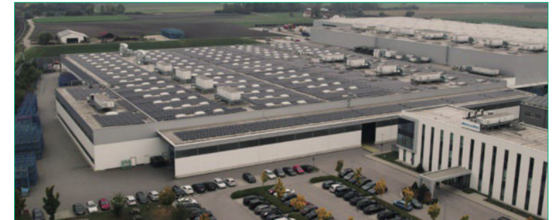
독일 성우(GMBH) 태양광 발전소
